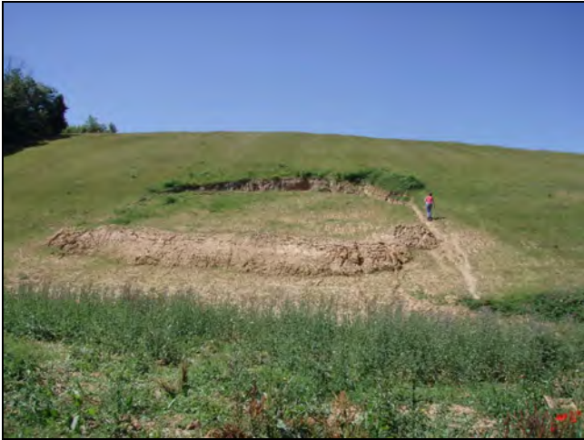
Versant situé au nord du village de Puycornet Loupe de glissement (vues de face et de profil)
